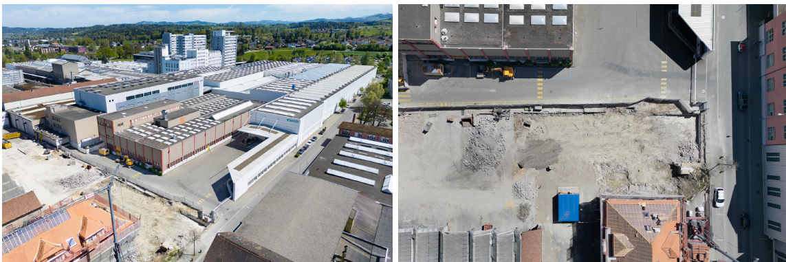
2) Rückbau des ehemaligen Bürogebäudes auf dem Areal / Aktuelle Situation Baustelle
